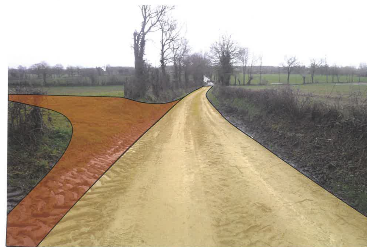
Figure 215 : Chemin rural à renforcer et chemin d'accès à créer pour l'accès à l'éolienne E3
