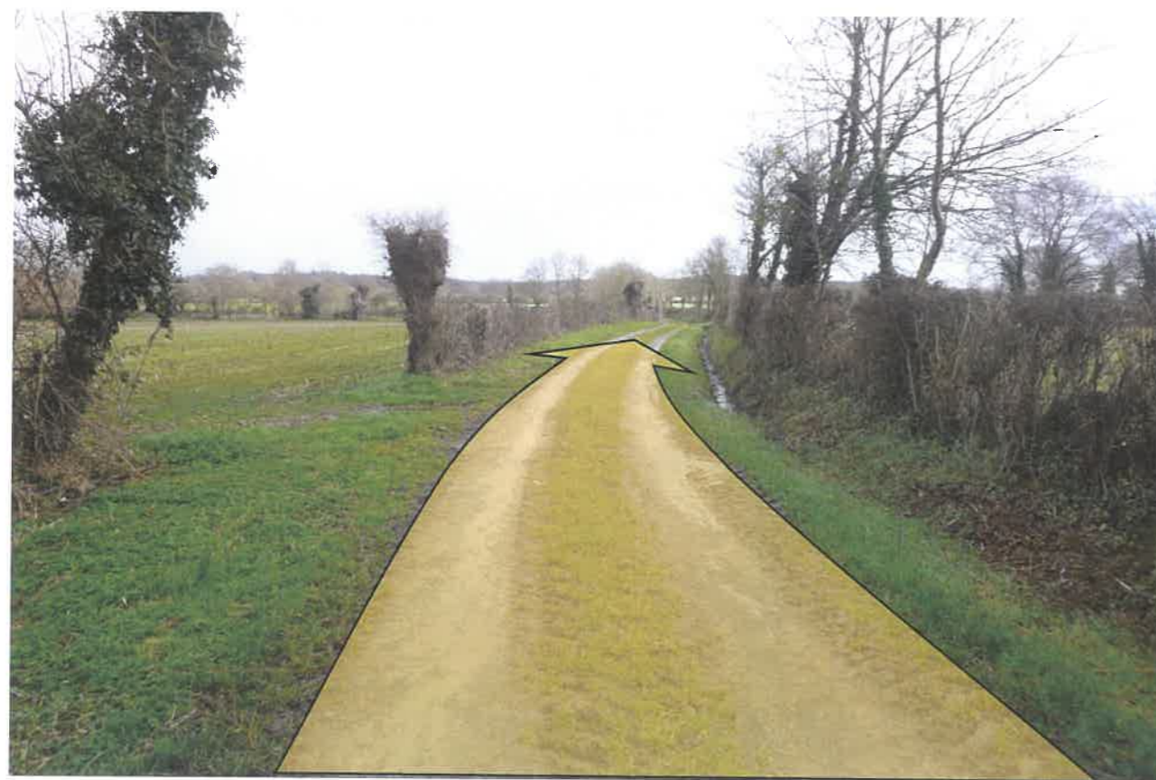
Figure 210 : Chemin rural renforcé pour l'accès à l'ensemble des éoliennes
