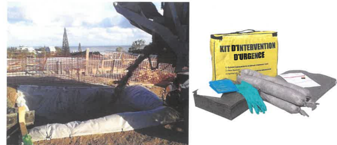
Figure 228 : Fosse de lavage du béton et kit anti-pollution (Source : Eurosoorb)
