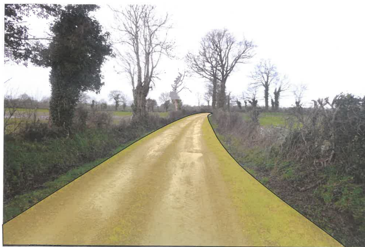
Figure 214 : Chemin d'exploitation à renforcer pour l'accès aux éoliennes E3 et E4
