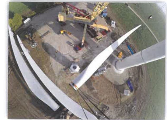
Figure 203 : Vue sur une plateforme de montage depuis la nacelle (Source : NORDEX)
